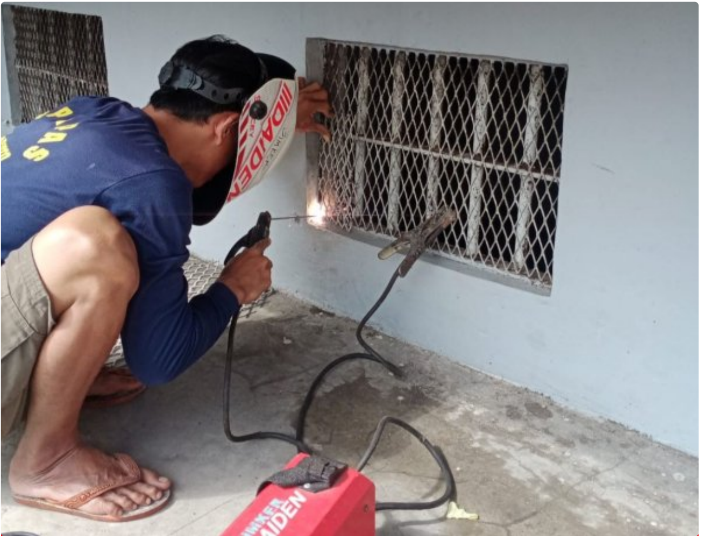
Lapas Kelas IIA Purwokerto Lakukan Rehabilitasi Bangunan
